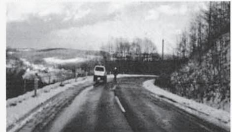
山間部の斜面による日陰部分が凍結路面となる
