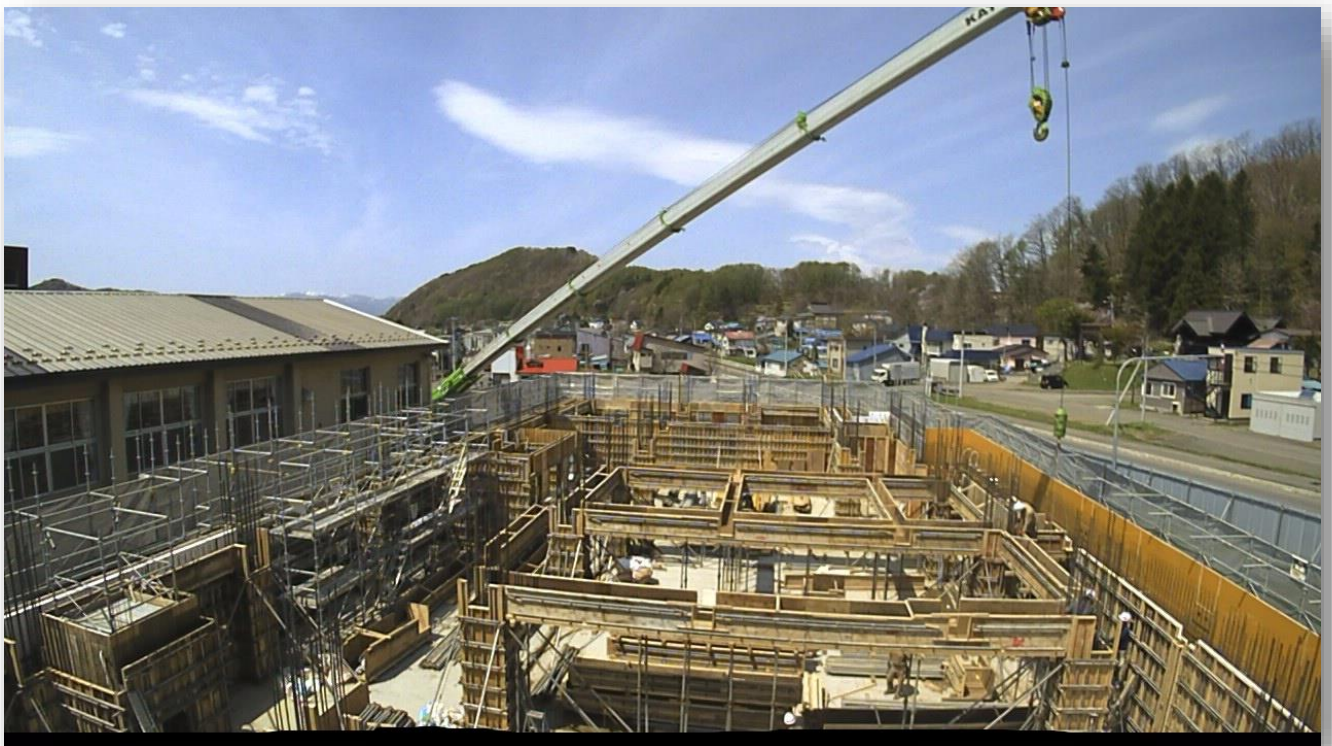
上砂川町役場庁舎建設工事
