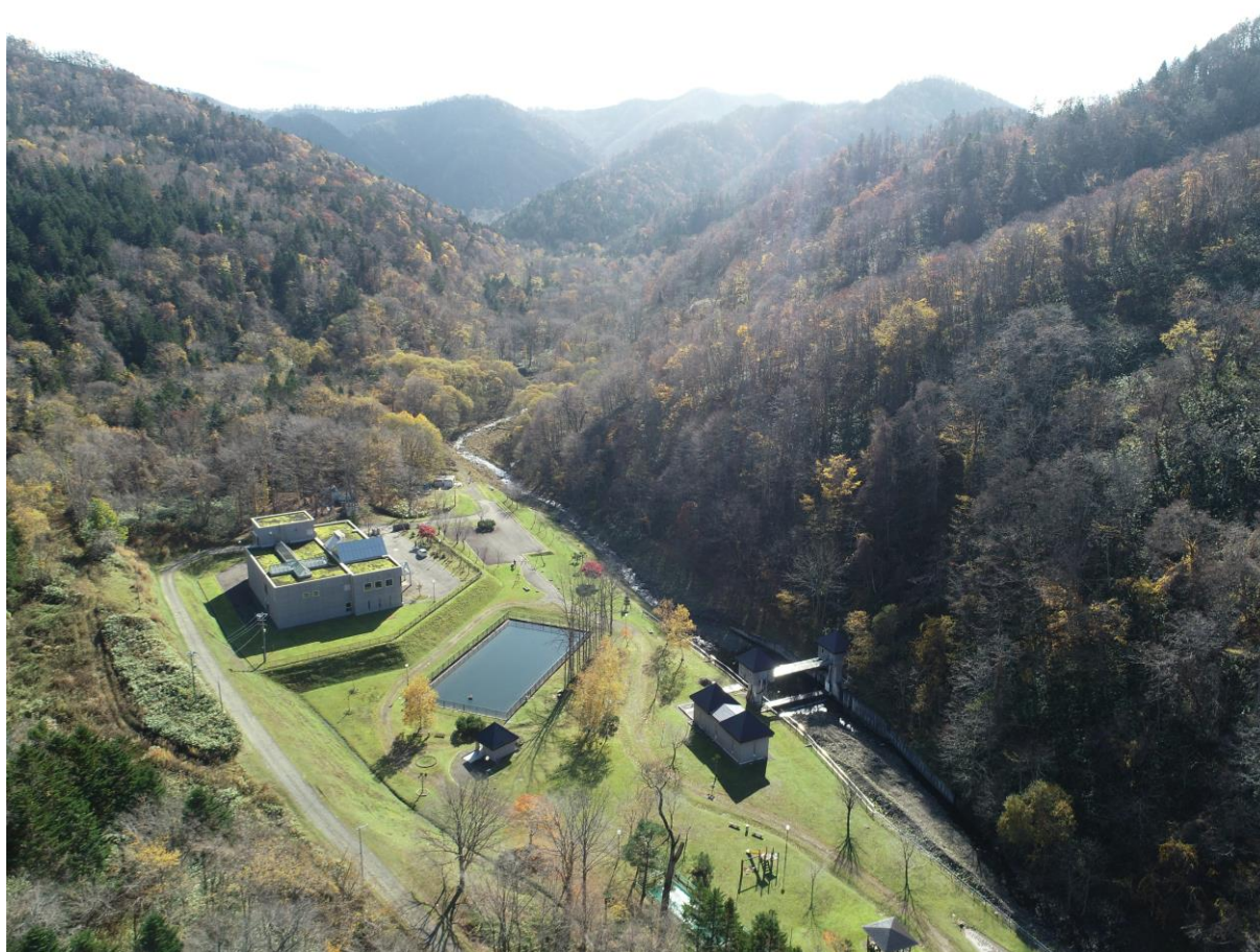
浄水場及び水源地
