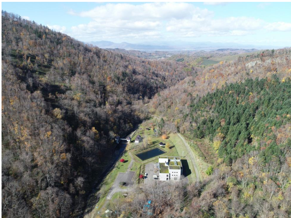
水源地から町を望む
