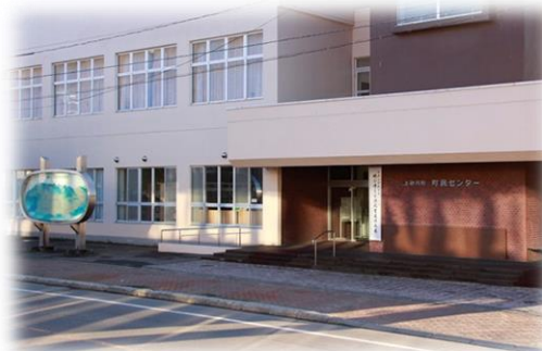
鶉本町第2期分譲団地(左) 町民センター(右)
